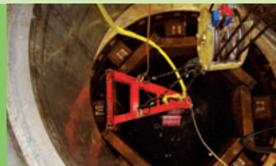
Zerlegung – Abbau des thermisches Schildes
