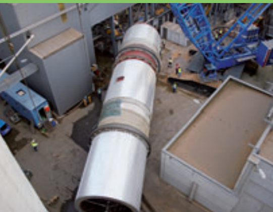
... am Kran angekommen ...
