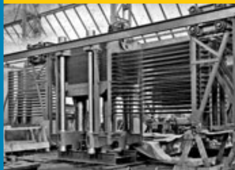
Sperrholzpresse mit Beschick- und Entleervorrichtung
