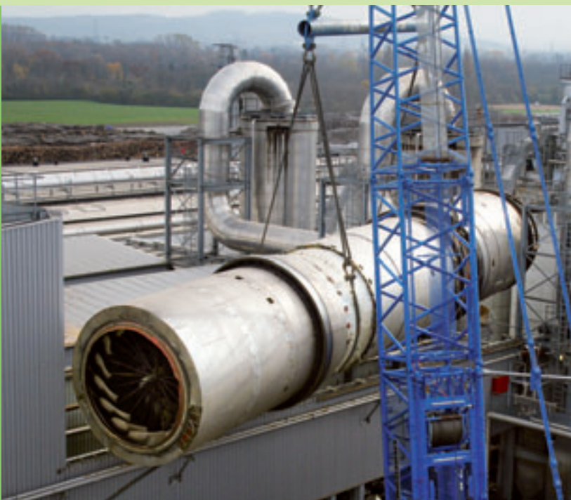
Ausbau des alten Trockners
