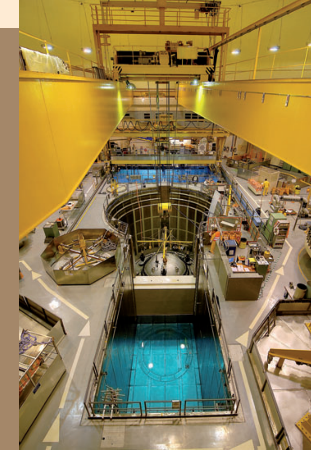
Blick in das Reaktorgebäude
