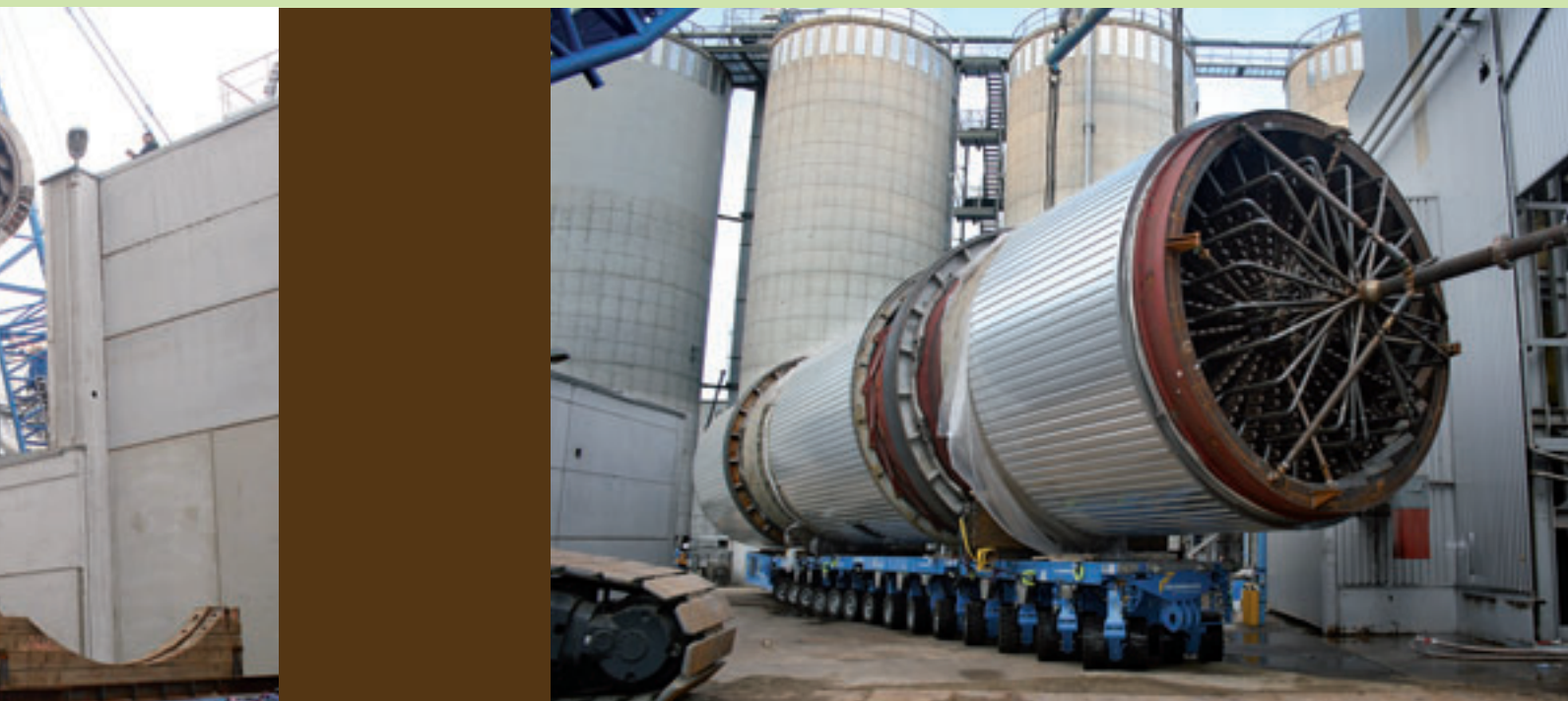
Transport des neuen Trockners
