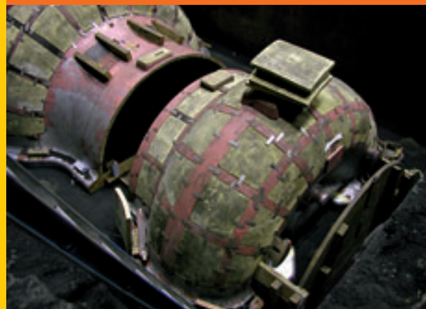
Einformen eines Turbinenteils
