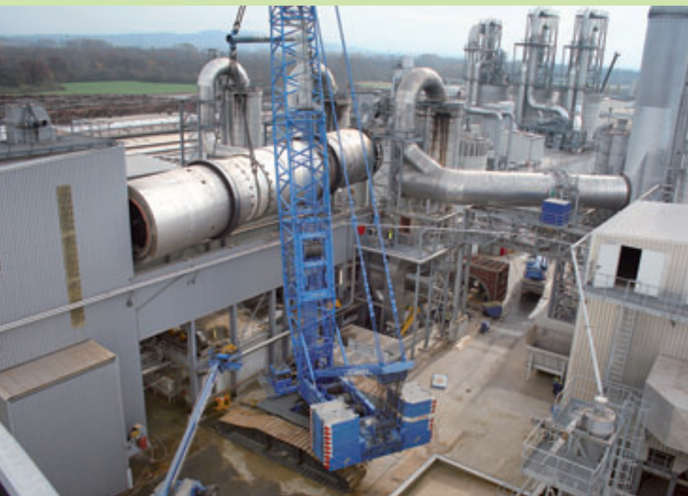
Ausbau des alten Trockners
