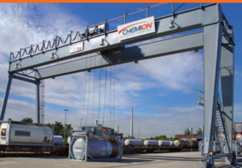
Vollportalkran 40 t x 28,00 m mit Containerspreader für Chemion
