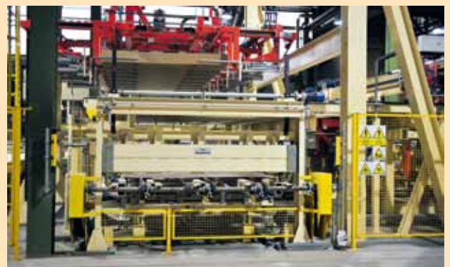
Oben: Brüdenabsaugung Unten: Abstapelung mit Schonplattenzuführung
