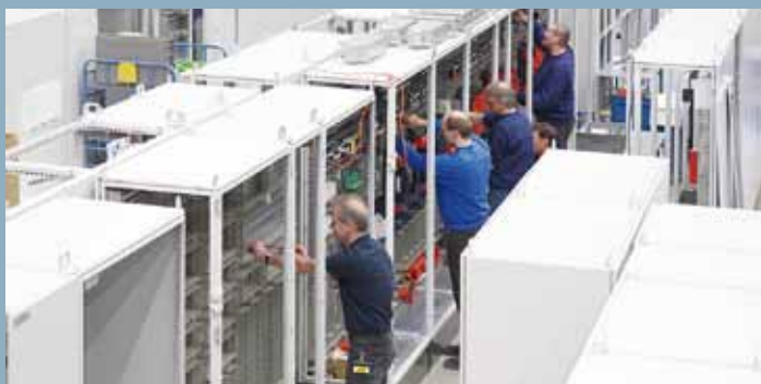
Schaltschrankfertigung bei ATR
